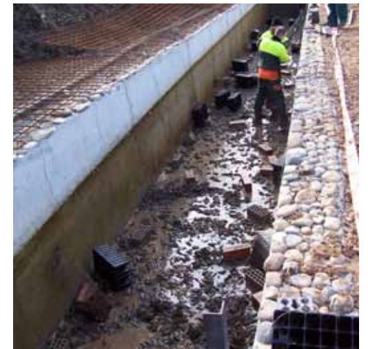
Piscines construïdes per acollir els crancs del canal de Gavet.
